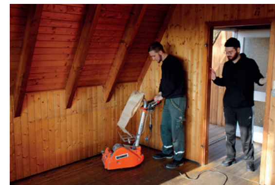
Bild 2: Hier wird der Holzboden fachgerecht abgeschliffen.
